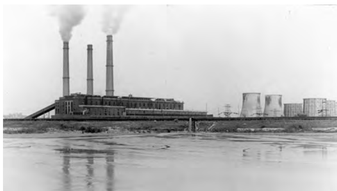
Rys. 2. Elektrownia Jaworzno II, lata 60. XX w. [6]
