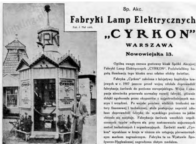
Rys. 3. Kiosk Sp. Akc. Fabryki Lamp Elektrycznych „CYRKON”
