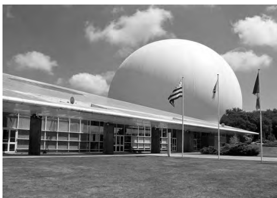
Rys. 7. Muzeum Telekomunikacji w Pleumeur-Bodou; widoczny balon to przykrycie pierwszej anteny telekomunikacji satelitarnej PB1-RADOM
